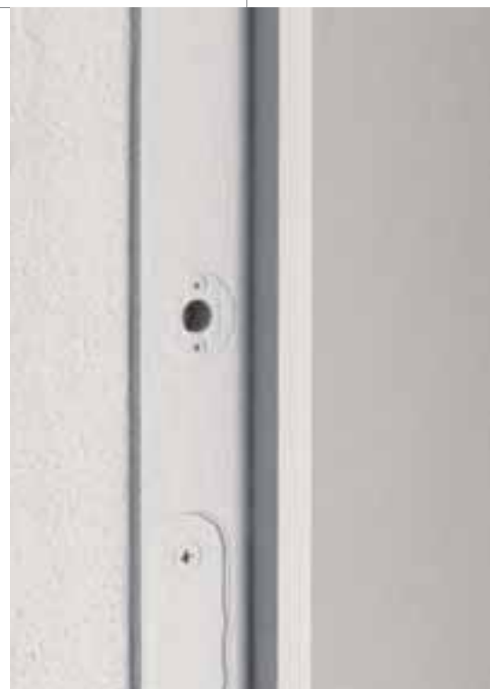
Противопожарные двери со специфическими болтами в коробе.
